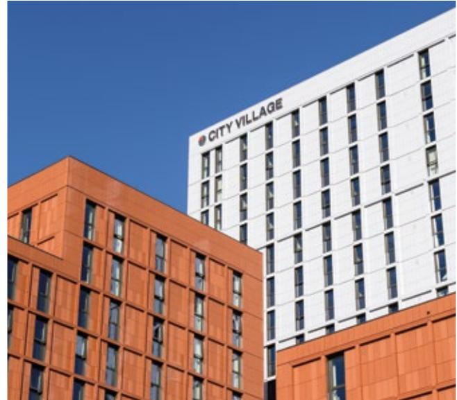
Fassadenkeramik von AGROB BUCHTAL in erdigen Farbtönen verkleidet, die mit den Ziegelgebäuden in dieser Gegend harmonieren. Der Turm ist in hellblau glasierten Platten des gleichen Systems mit glänzender Glasur ausgeführt. Diese hellgetönte Keramik mit ihrer reflektierenden Oberfläche lässt den Turm leichter erscheinen und erhellt ihn gleichermaßen, was für Coventry einen willkommenen zusätzlichen Glanz bedeutet.
