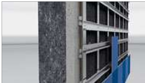
KerAion®-Platten mit den rückseitigen Agraffen in die horizontalen Schienen einhängen
